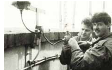
Wartungsarbeiten Flughindernisleuchte
