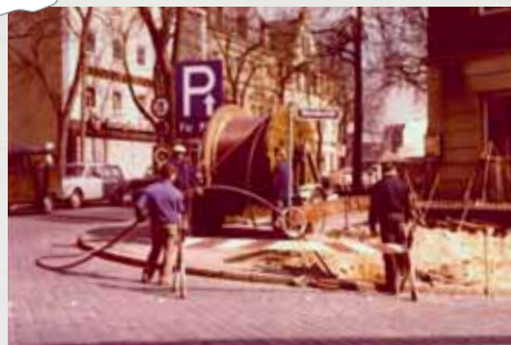
Verlegung PE Kabel
