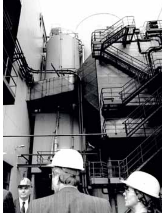
Einweihung der Rauchgasentschwefelungsanlage im HKW 1986
