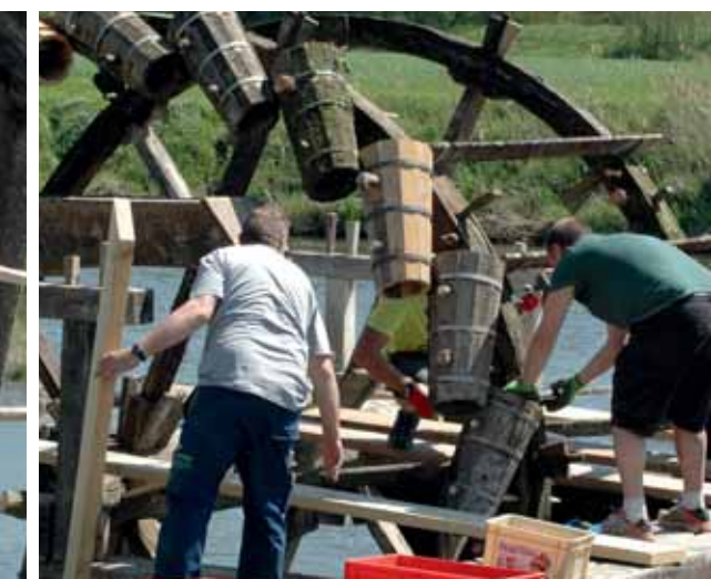
Mit einer ganzen Mannschaft wird das Rad jedes Frühjahr neu zusammgebaut und ins Wasser gesetzt
