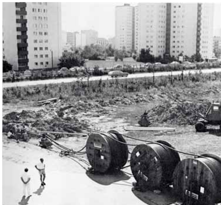
Verlegung des 110 kV-PE-Kabels, Rechts: Windenwagen im Einsatz
