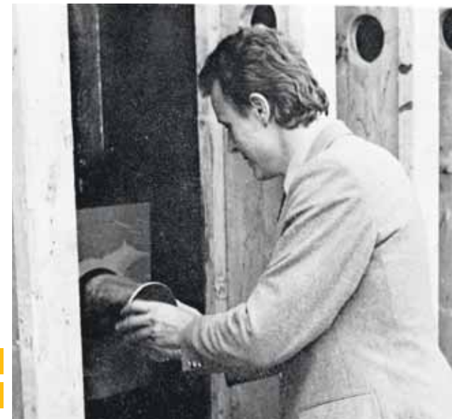
Grundsteinlegung durch OB Dr. Hahlweg
